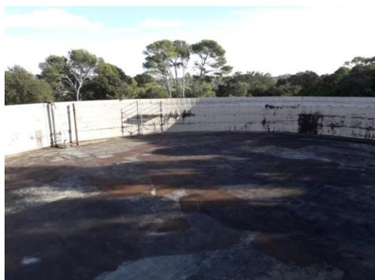
Des travaux de nettoyage et de maintenance sont en train d'être réalisés sur le bassin rond. La vidange totale a permis un curage des boues de décantation, un nettoyage des parois et une expertise béton réalisée par un ingénieur spécialisé. D'une capacité de 4 000 m<sup>3</sup>, ce bassin est alimenté par l'eau de la nappe phréatique dans une limite de 60 m<sup>3</sup>/jour avec une double vocation :
